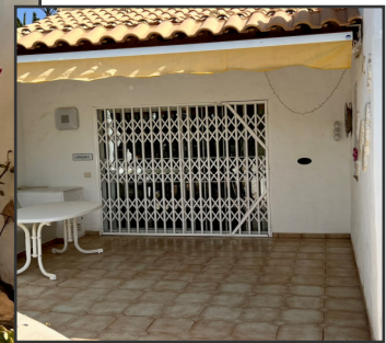
Sicherung durch Scherengitter
